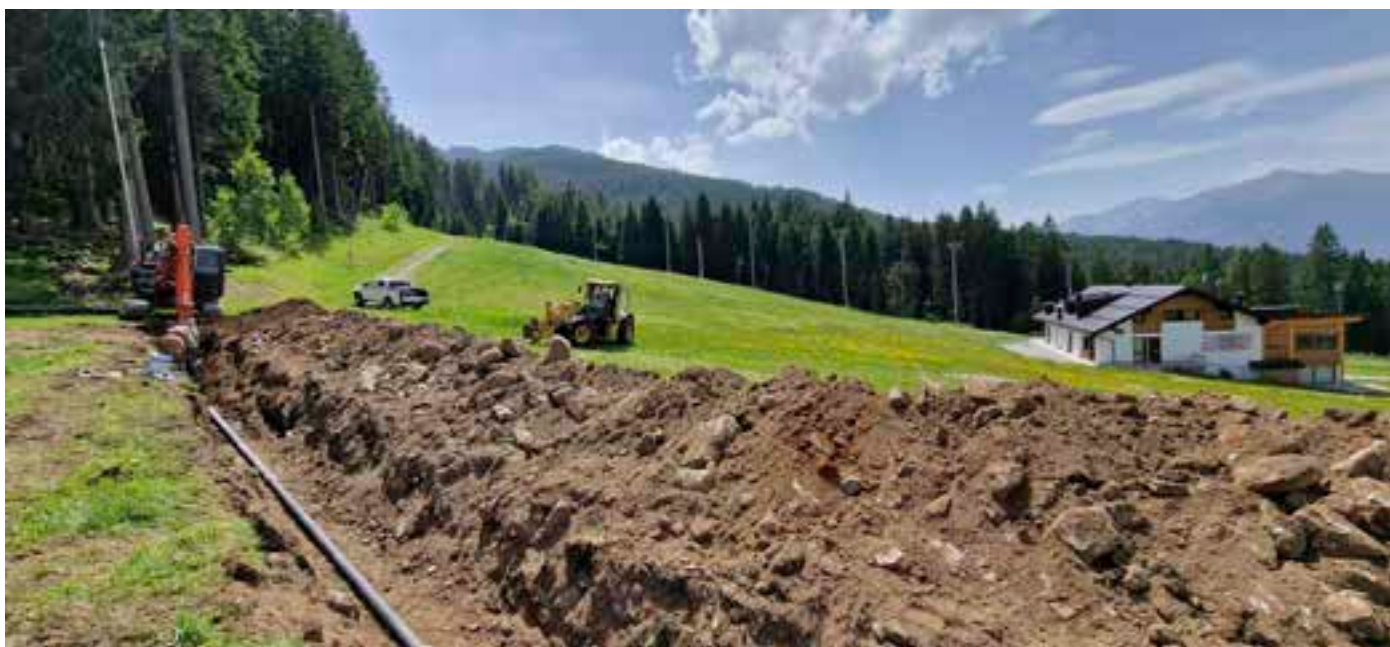
Potenziamento innevamento Marilleva 1400
