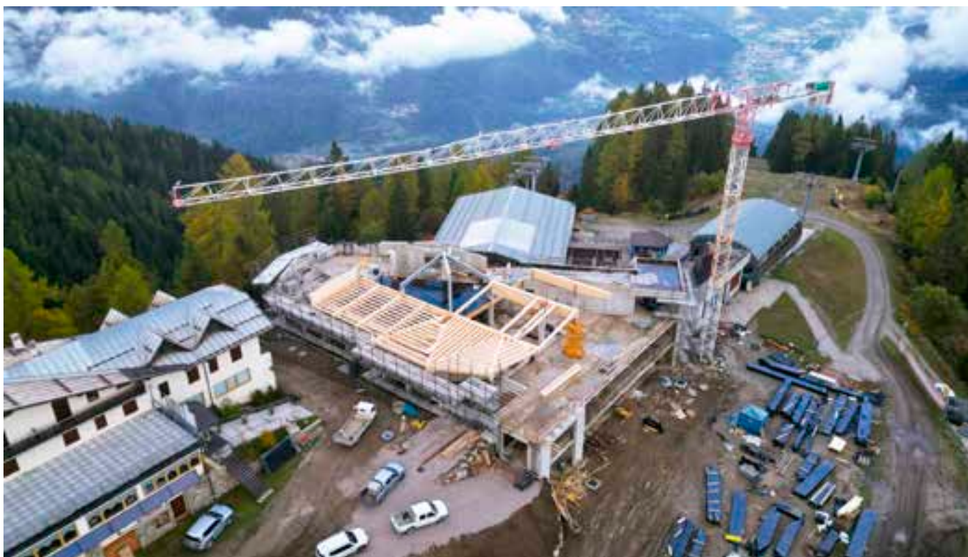
Immobilie Malghet Aut - Fasi di costruzione (vista sopraelevata)
