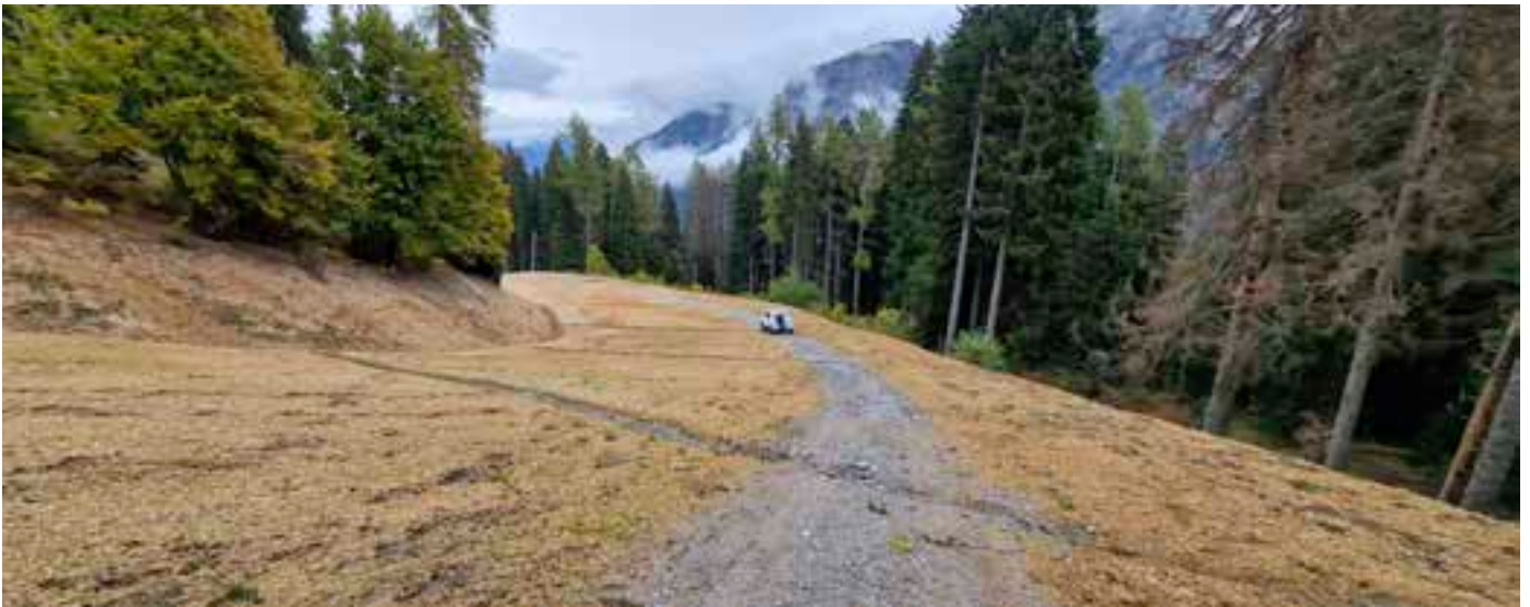
Pista Belvedere - Semina e pacciamatura a fine lavori
