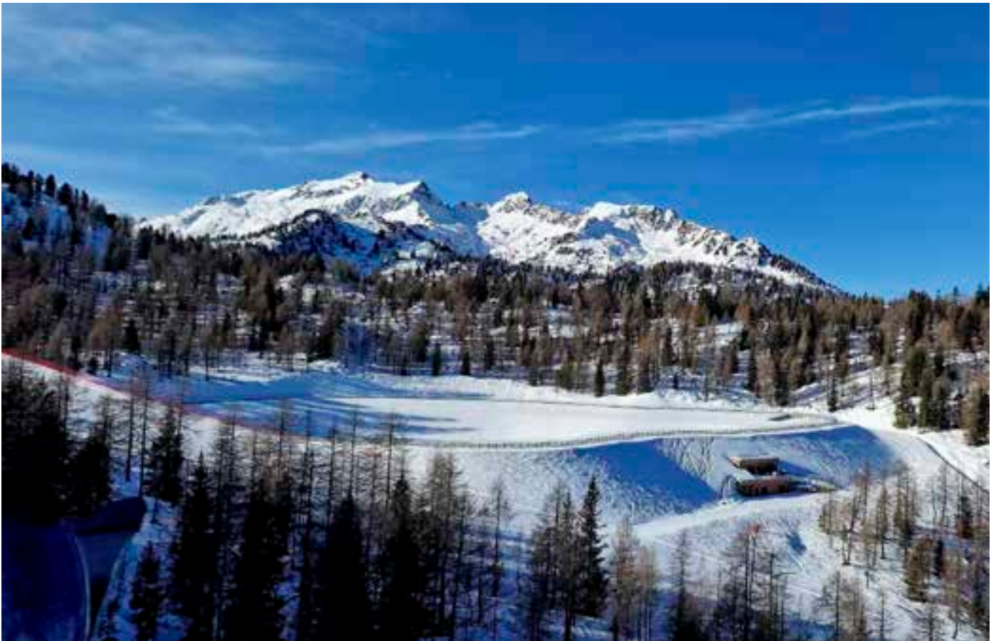
Bacino Mastellina con stazione di pompaggio incastonata nel rilievo
