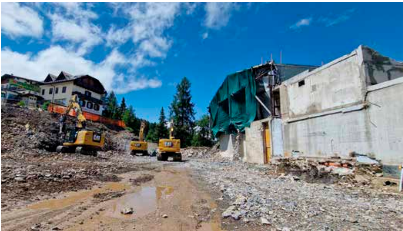
Immagine Malghet Aut - Fasi di demolizione
